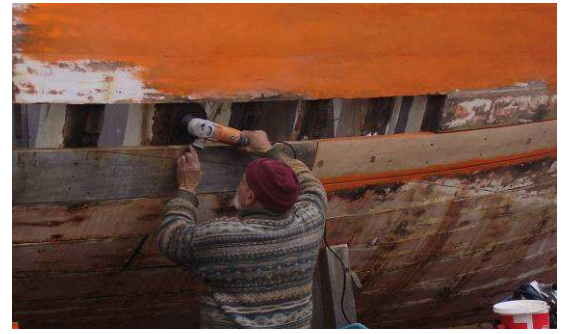
Démontage des bordés Parage des membrures
