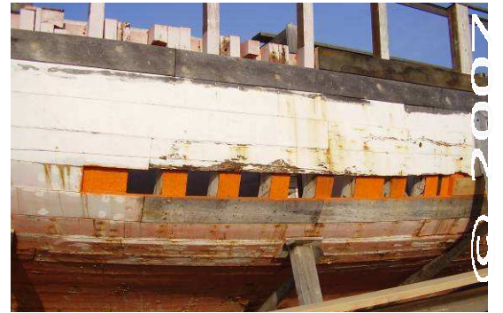
Traitement des membrures
